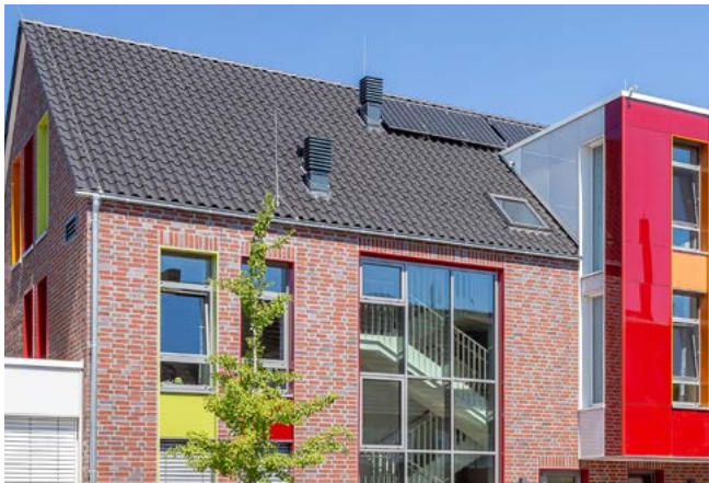
Z5 altschwarz Albrecht-Bedachungen GmbH, Hamm
